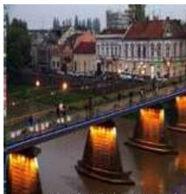
Пішохідний міст в м. Ужгороді
